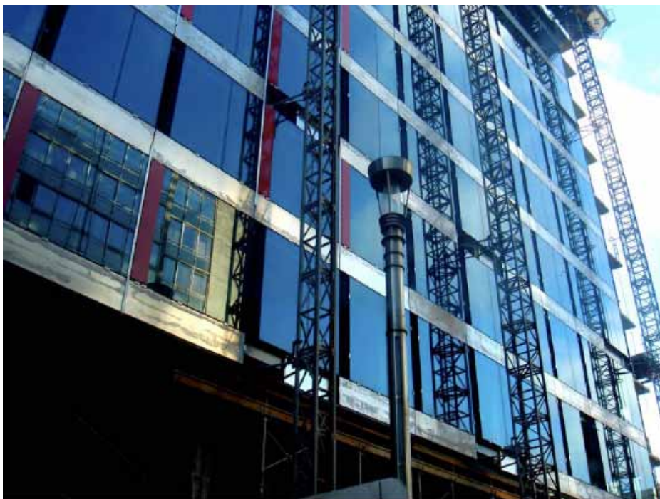
Immeuble du quartier des affaires de Bruxelles en cours d'achèvement : protection totale contre les champs électromagnétiques et vitrages spéciaux
