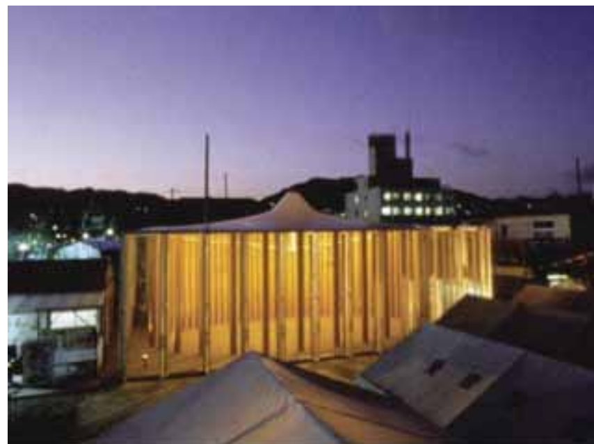
Eglise en papier à Kobe (Japon), construite après le tremblement de terre de 1995 par Shigeru Ban
