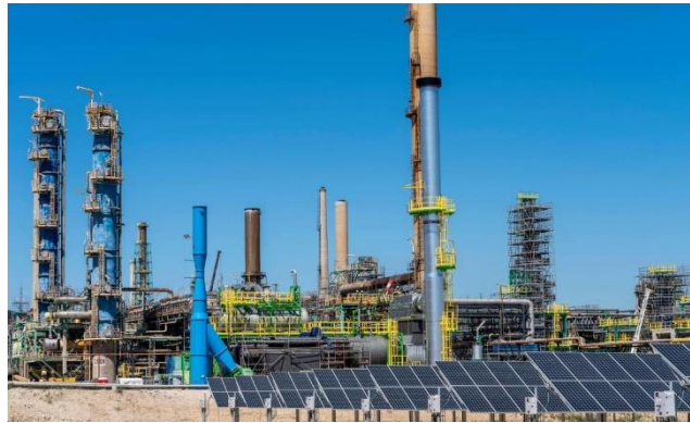
Raffinerie de la Mède © 2022 TotalEnergies
