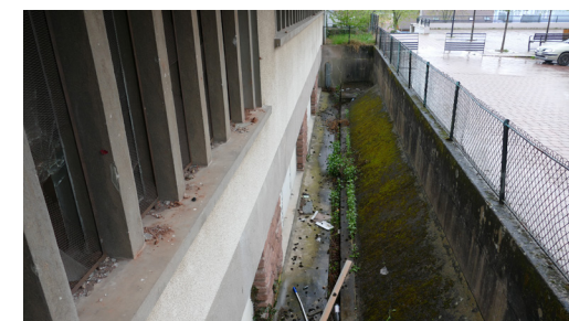
La présence d'amiante dans les conduits, qui oblige à ajouter une opération de désamiantage. Comment faire du chantier l'occasion de certains usages ?
