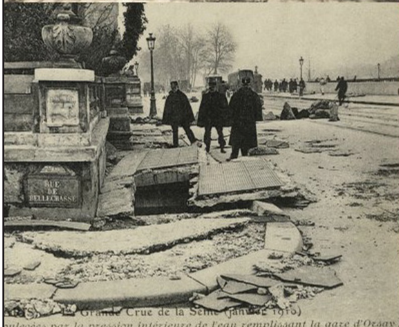
LA GRANDE CRUE DE LA SEINE (Janvier 1910) Effondrement de la voûte d'un égout. — ND Photo.
