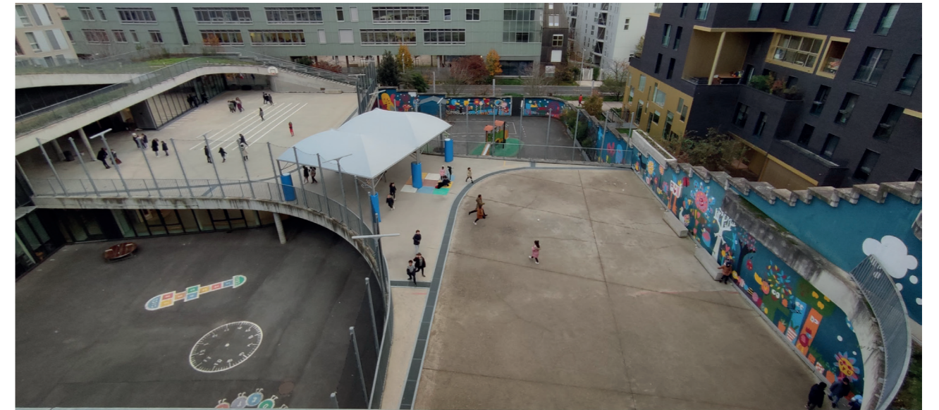
▲ LES COURS DE RÉCRÉATION, CHAUDES, ÉBLOUISSANTES, VIDES (VUES DEPUIS LE TOIT)
