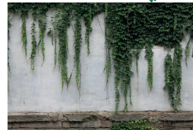
Des plantes retombantes plantées sur chaque balcon viendront faire de l'ombre devant les verrières de l'étage du dessous.
