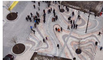
Marbre d'ici prend la forme d'une grande dalle en béton de 260 m 2 (plus de dix tonnes de gravats provenant de la démolition des immeubles et entrepôts du quartier), Place du Général de Gaulle, Ivry-sur-Seine, 2016.
