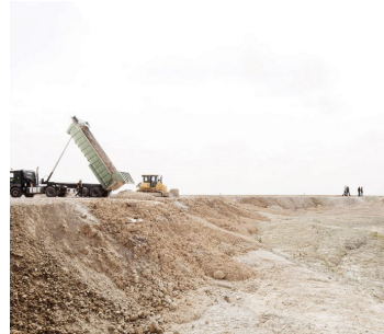
Valorisation des déblais issus des excavations des chantiers du Grand Paris Express.
