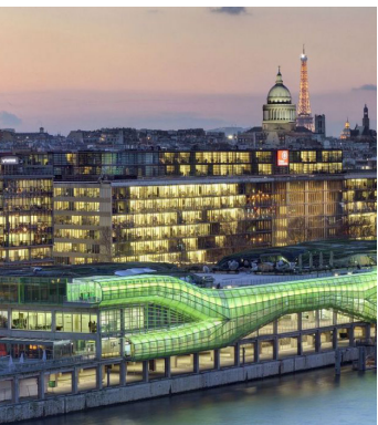
Cité de la mode et du design , greffe d'une construction neuve sur une structure en béton, Paris 13e.
